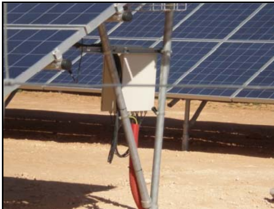
Figura 2.7 – Arranjo Mecânico dos Elementos de Proteção e Aterramento CENTRAL GERADORA SOLAR FOTOVOLTAICA TAUÁ – TAUÁ / CE
