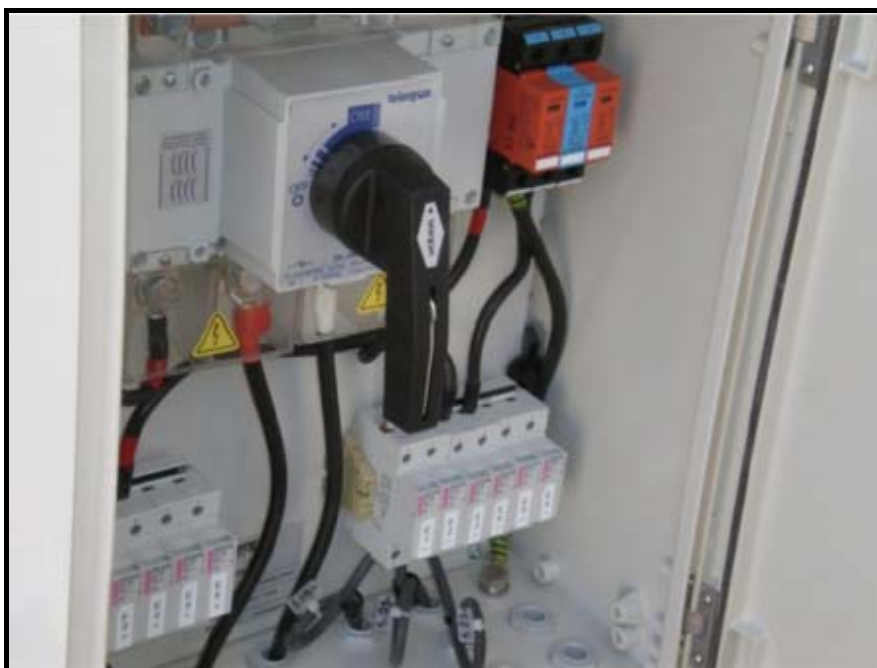
Figura 2.8 – Composição Básica do Elemento de Proteção e Aterramento CENTRAL GERADORA SOLAR FOTOVOLTAICA TAUÁ – TAUÁ / CE
